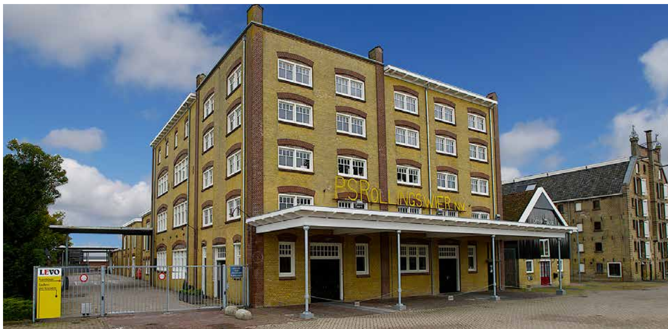
Het pand in Franeker
