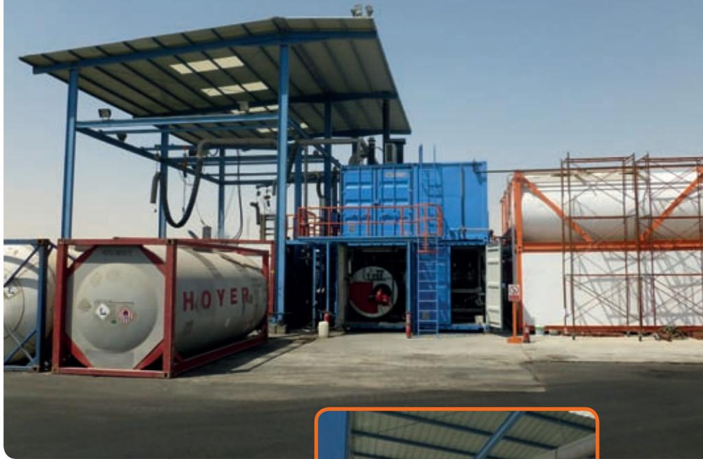
een fysisch-chemische voorzuivering. Door alles driedimensionaal uit te tekenen kon op voorhand en in overleg met Kanoo de exacte locatie van de verschillende installatieonderdelen bepaald worden. Door de opbouw in containers kon de installatie zeer snel operationeel zijn. ■
