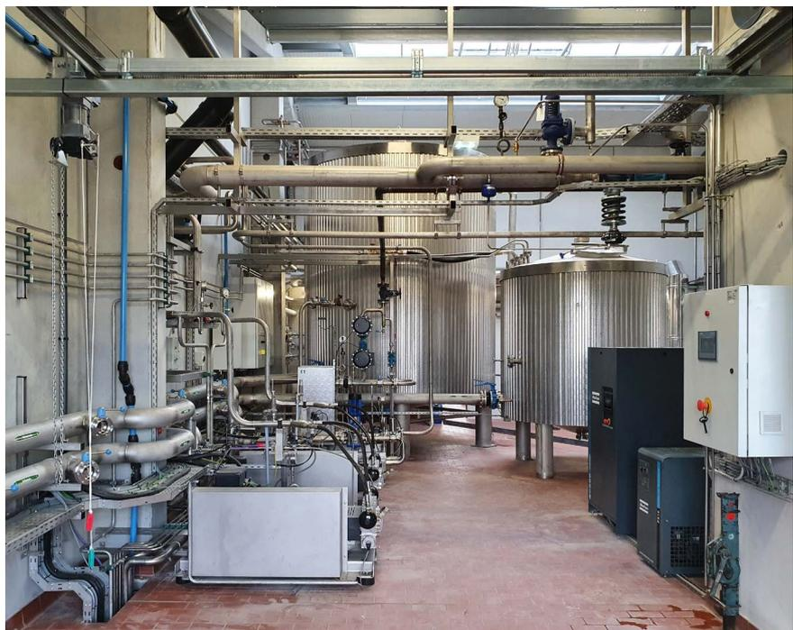
Die Tankinnenreinigung verfügt über zwei Waschbahnen, die jede in zwei Positionen verteilt sind. Mit vernünftiger Gröninger Software können sowohl Container als auch Tankwagen mit mehreren Kompartimenten gereinigt werden. Für die Heizung der beladenen Tanks
