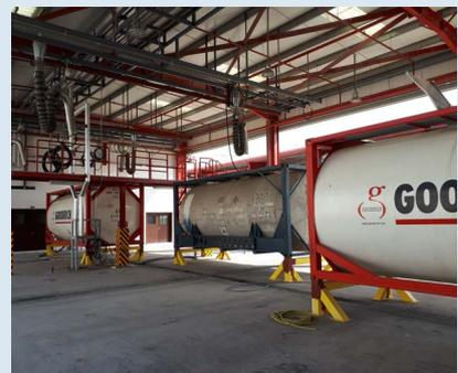
Reinigung der Tankcontainer mit chemischen Restladungen. Zur effizienten und umweltfreundlichen Verarbeitung dieser Restladungen wurde es ermöglicht, das Abwasser in verschiedene Ströme zu trennen. Mit einer physikalisch-chemischen Klärung, ergänzt mit einem Sandfilter und einem Aktivkohlfiler wird das Spülwasser derart geklärt, dass alle Forderungen der Behörde erfüllt werden. Freigekommener Schlamm wird mit Hilfe einer Zentrifuge entwässert, wonach dieser Schlamm abgeführt wird.
