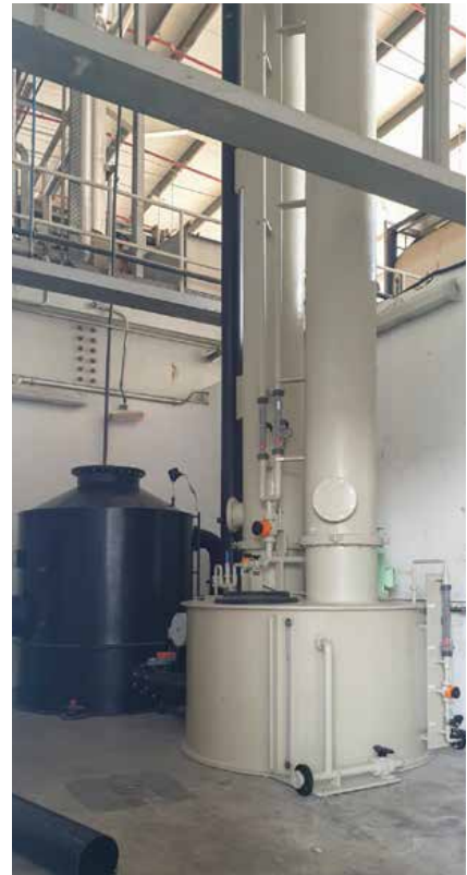
Gaswascher mit Kohlfiter im Hintergrund (RSA Talke Dubai)
