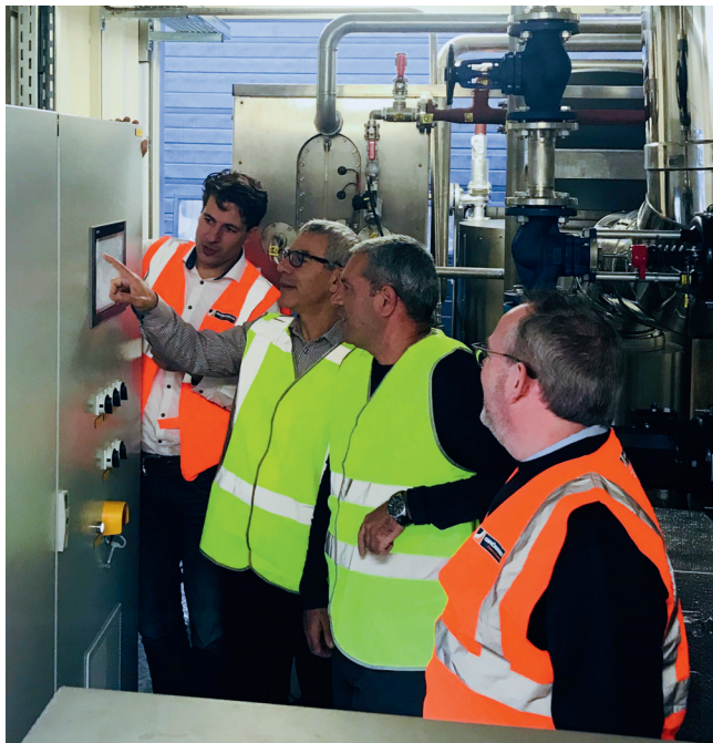
Gold Bond in Rotterdam für den Factory Acceptance Test (FAT)
