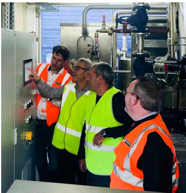
Gold Bond in Rotterdam voor de Factory Acceptance Test (FAT)
